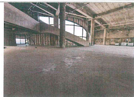
Estado Actual Nivel Galerías
