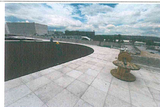
Estado Actual Nivel Azotea
