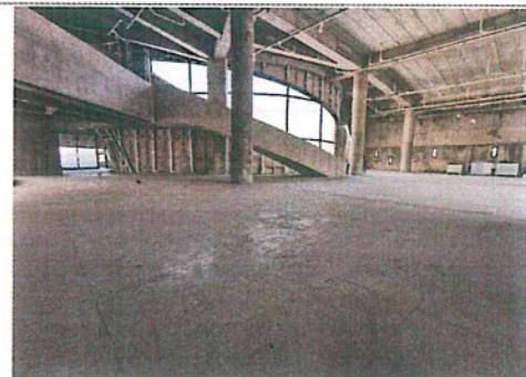
Estado Actual Nivel Galerías
