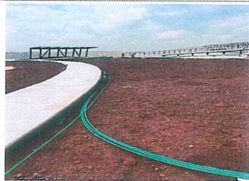
Estado Actual Nivel Azotea
